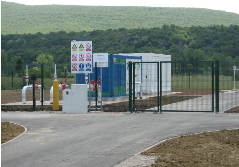
Slika 18. - Tipska kontejnerska mjerno-redukcijska stanica
